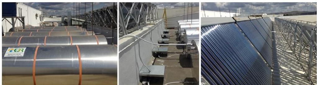
Figura 06 – Sistema Ativo Direto (Circulação Forçada)
