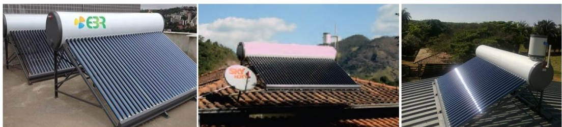
Figura 09 – Aquecedor Solar de Boiler Acoplado em Tubo Evacuado (TEAAG)
