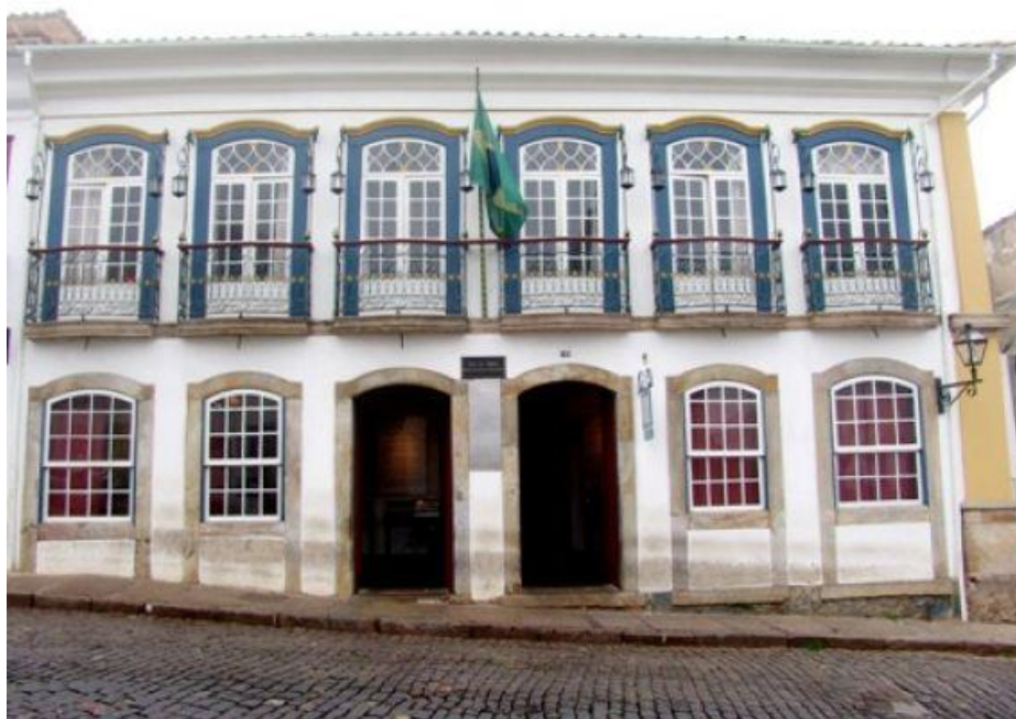
FIGURA 3 – Prédio da Câmara Municipal de Ouro Preto Fonte: www.cmop.mg.gov.br
