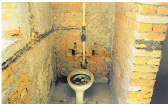
Figura 5 - Banheiro da cela no início das reformas. Foto: Acervo Arquivo do Estado de São Paulo, por volta dos anos 2000.
