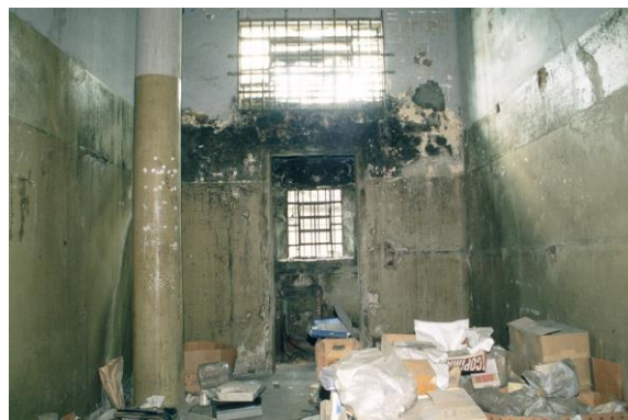
Figura 3 - Interior de uma das celas durante a reforma, provavelmente entre 2000 e 2001. Foto: Fernando Braga. Acervo: Arquivo Público do Estado de São Paulo.
