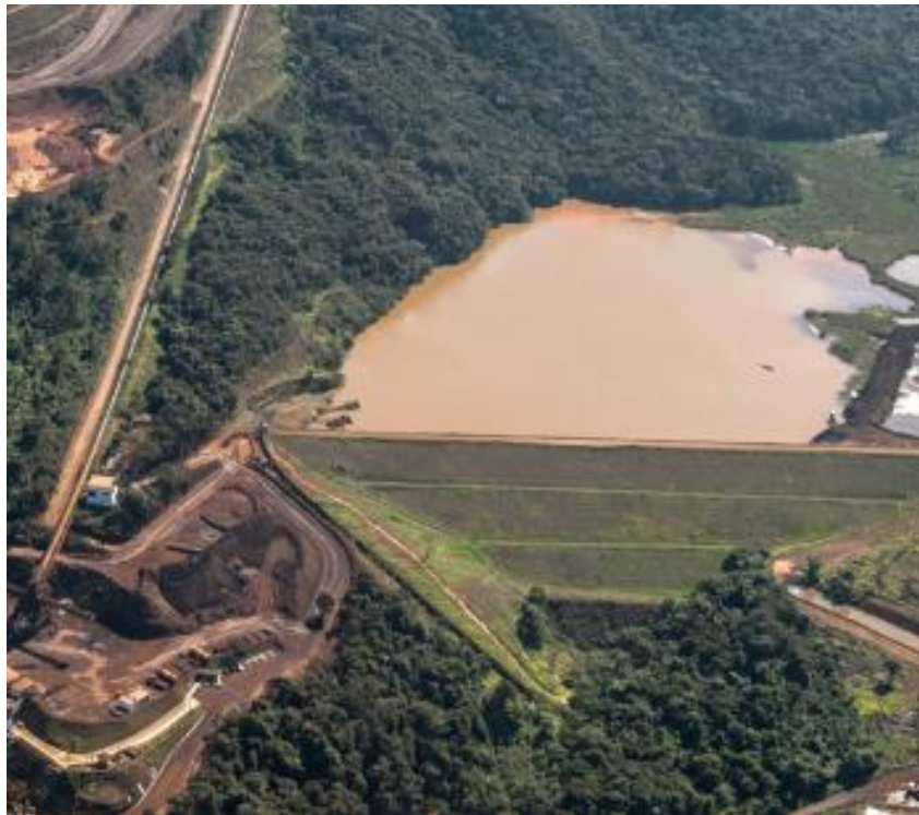
Figura 1 – Foto da Barragem 1 da Mina Córrego do Feijão
