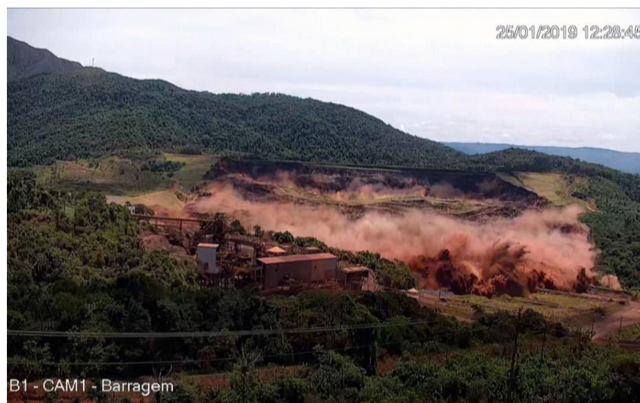
Figura 2 – Foto do rompimento da barragem 1 da Mina Córrego do Feijão
