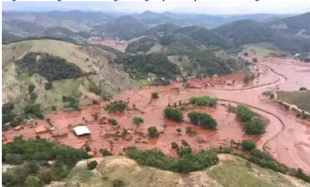
Figura 1 – Imagem aérea da região atingida pelo rompimento da barragem de Fundão
