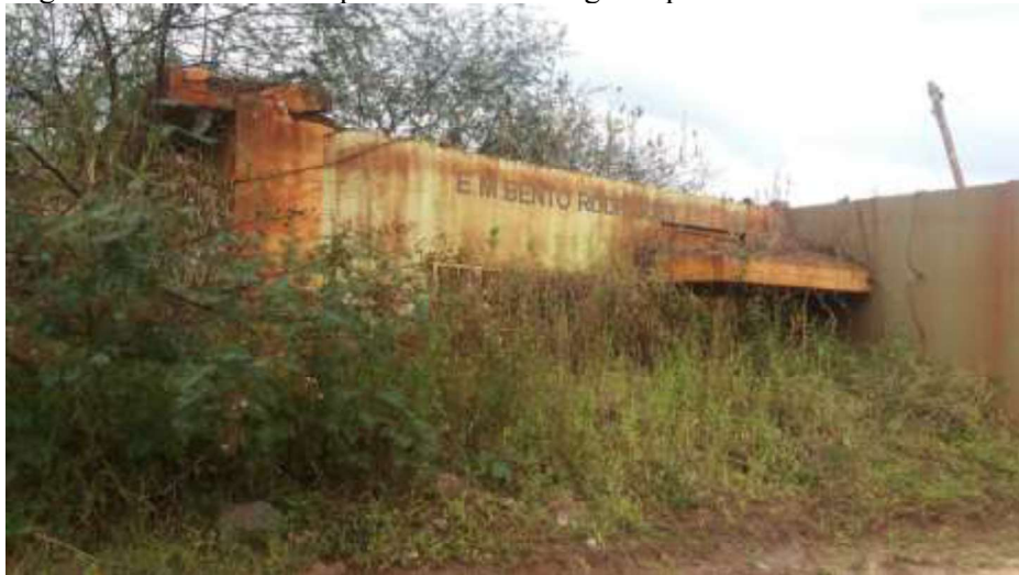
Figura 4 – Escola Municipal de Bento Rodrigues após 5 de novembro de 2015
